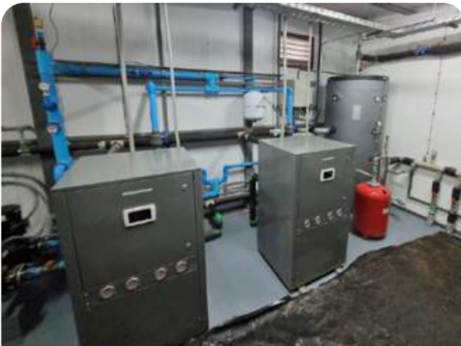
Bombas de calor y estanque de inercia.
