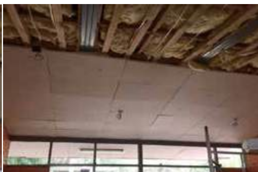
Instalación de EPS en cielo.
