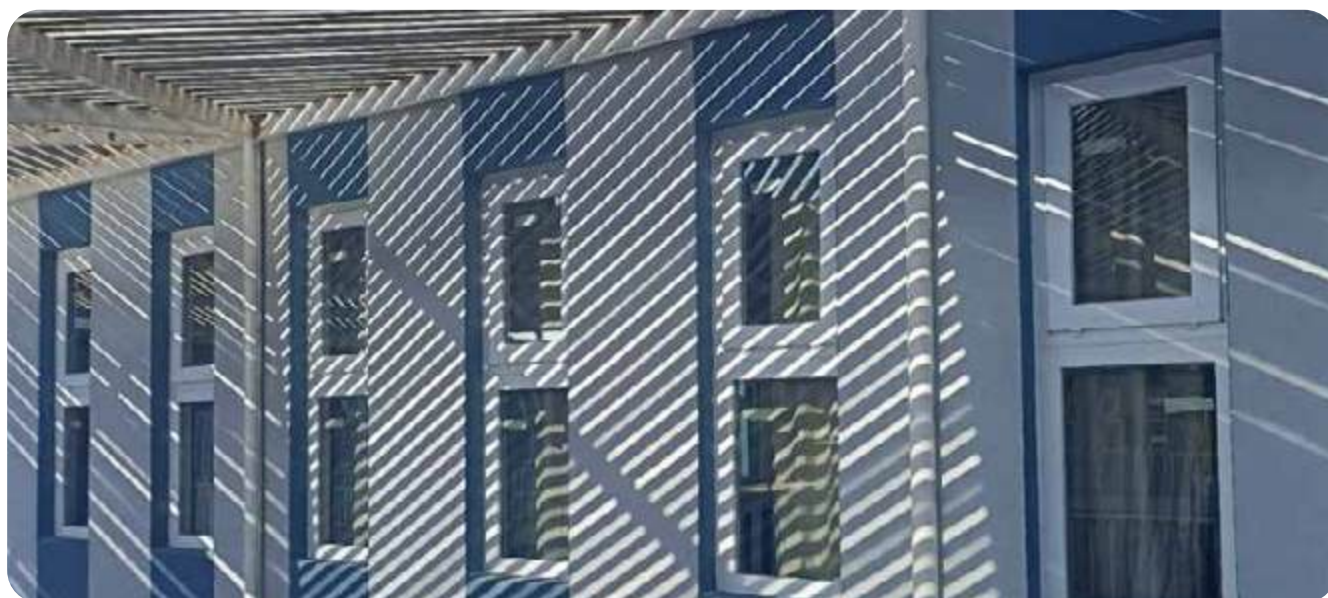
Nuevas ventanas de doble vidrio hermético con marcos de PVC. Se aprecia la sombra tamizada de los sombreaderos.
