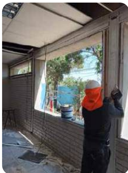
Instalación EPS baja densidad en perfiles omega.
