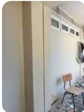
Junta entre pilares.
