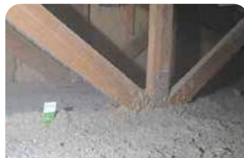
Celulosa aplicada en cielo horizontal
