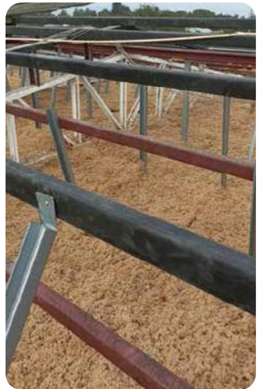
Aplicación de celulosa en cielo horizontal.
