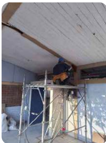
Instalación huinchas MDF sobre perfiles omega.
