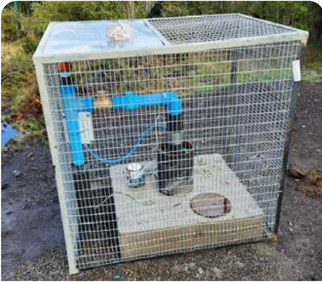
Pozo de Extracción y Bomba de Pozo.
