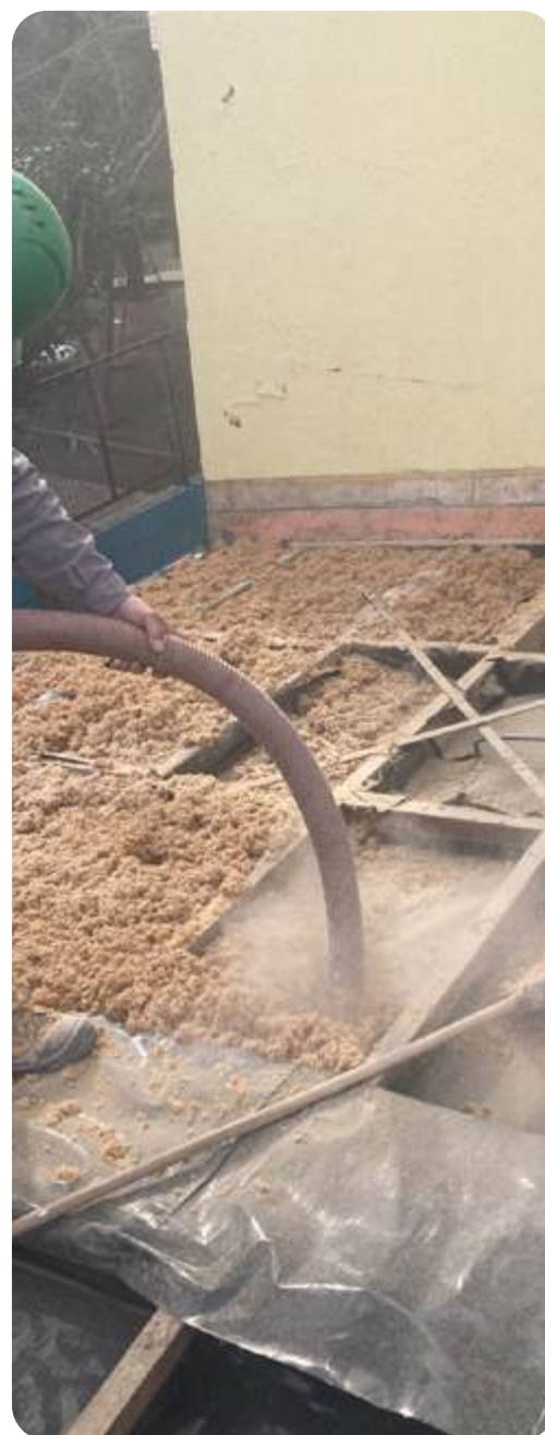
Celulosa aplicada en cielo horizontal
