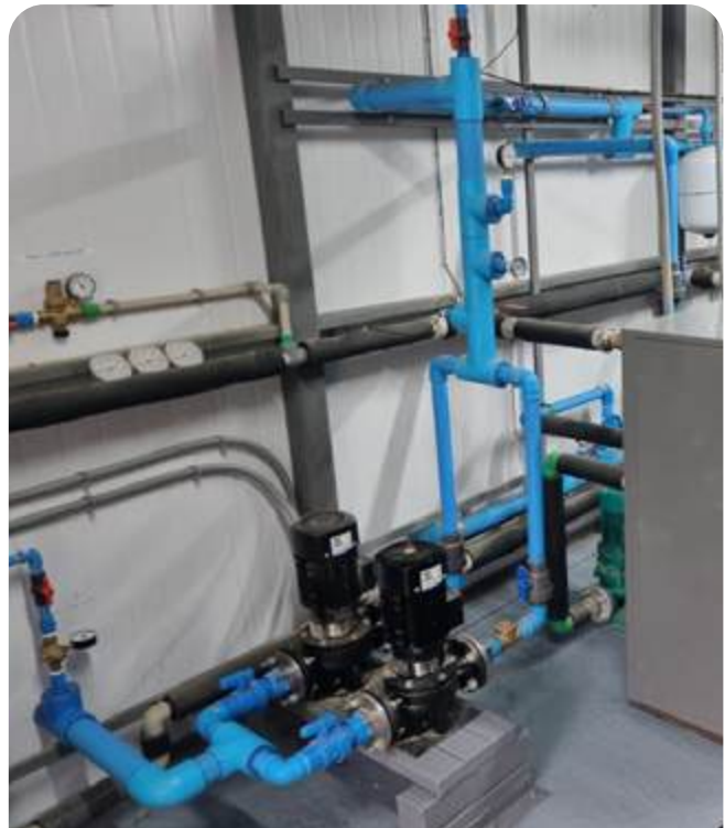
Bombas de sistema de loops subterráneos.
