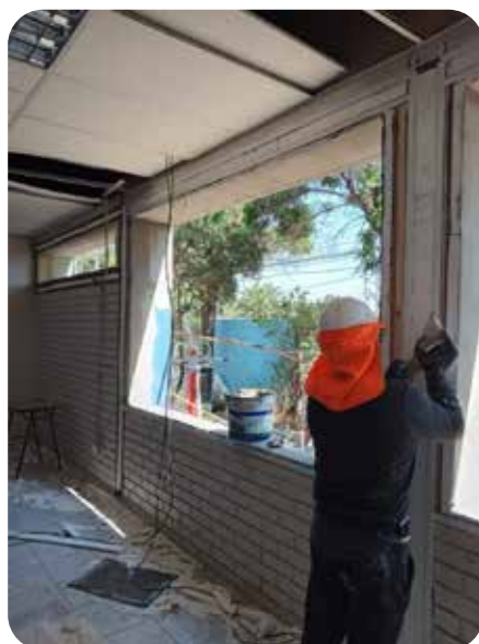
Instalación EPS baja densidad en perfiles omega.
