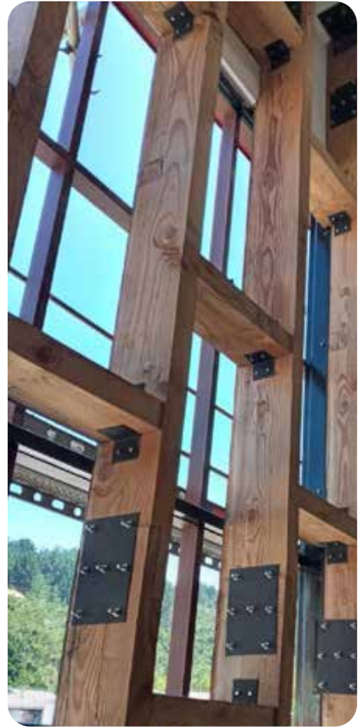
Vista interior de Fachada Poniente con estructura adicional por el exterior para recibir muro cortina.
