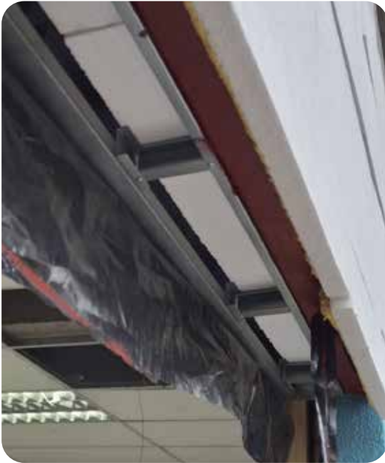
Sobre estructura en acero galvanizado encuentro muro-losa del 2º piso con viga de 1º piso.
