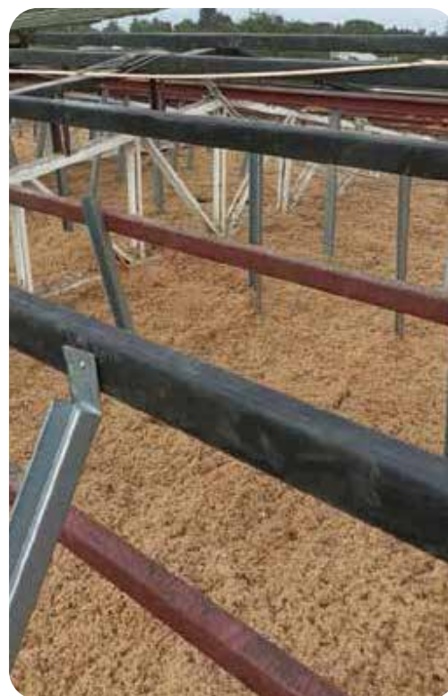
Aplicación de celulosa en cielo horizontal.
