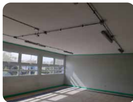
Escuela terminada, interior sala de clases.
