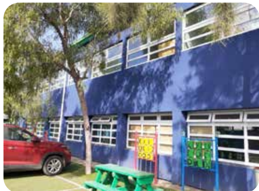
Juntas entre muro y pilar.
