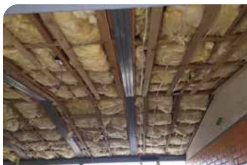
Cielo inclinado con capa de lana de vidrio y costaneras en el otro sentido.
