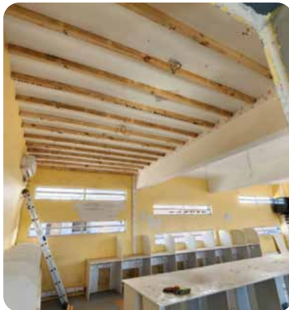
Instalación de aislación térmica en muros con sistema EIFS | Imagen 4. Preparación de cielo para recibir lana de vidrio de 50 mm de espesor.
