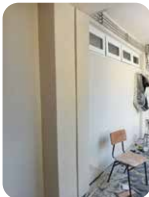
Junta entre pilares.
