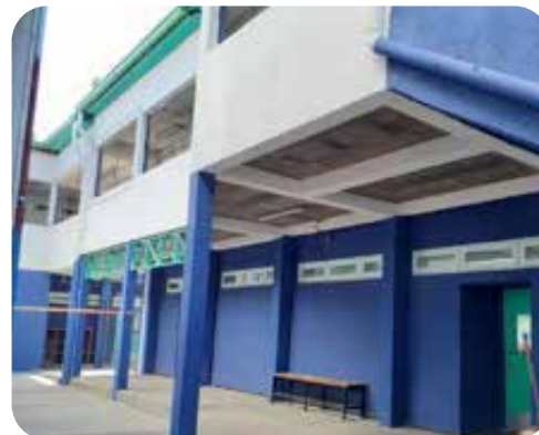
Junta entre pilares y muros.
