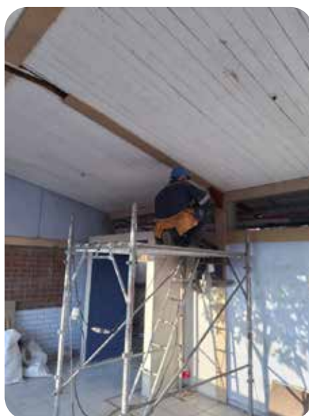
Instalación huinchas MDF sobre perfiles omega.
