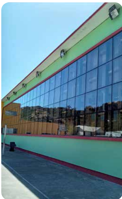
Vista exterior de Fachada Poniente finalizada.
