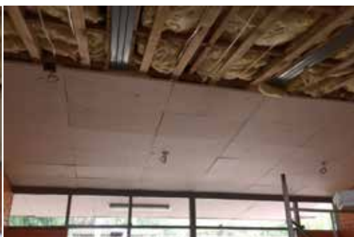
Instalación de EPS en cielo.
