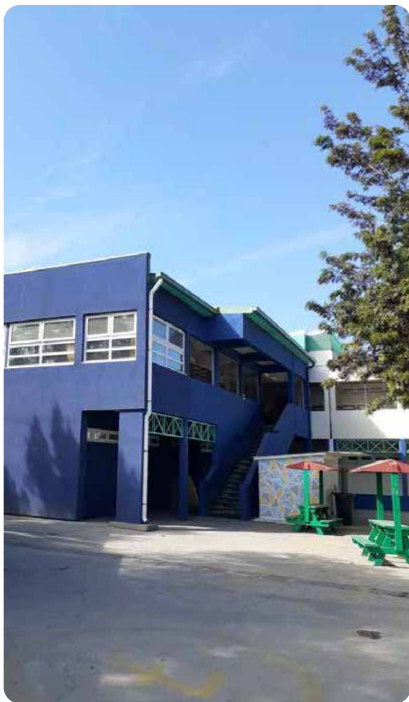
Escuela terminada fachada poniente.
