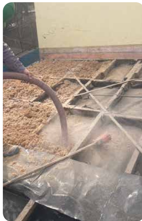
Aplicación primera capa de celulosa en cielo inclinado.
