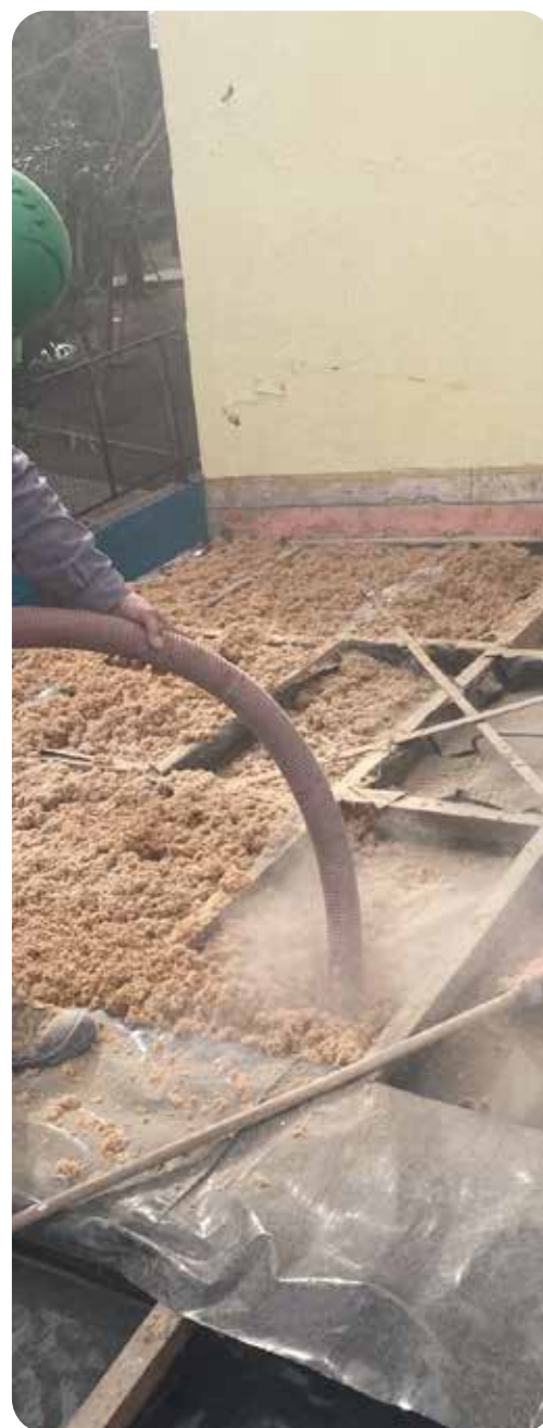
Celulosa aplicada en cielo horizontal
