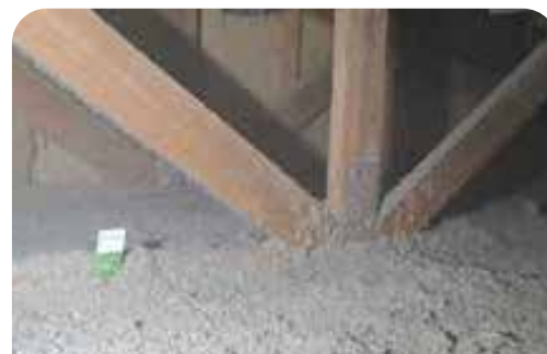
Celulosa aplicada en cielo horizontal
