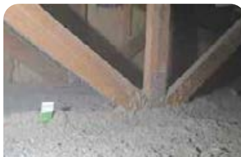
Celulosa aplicada en cielo horizontal
