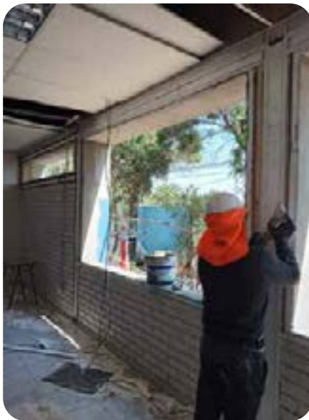
Instalación EPS baja densidad en perfiles omega.
