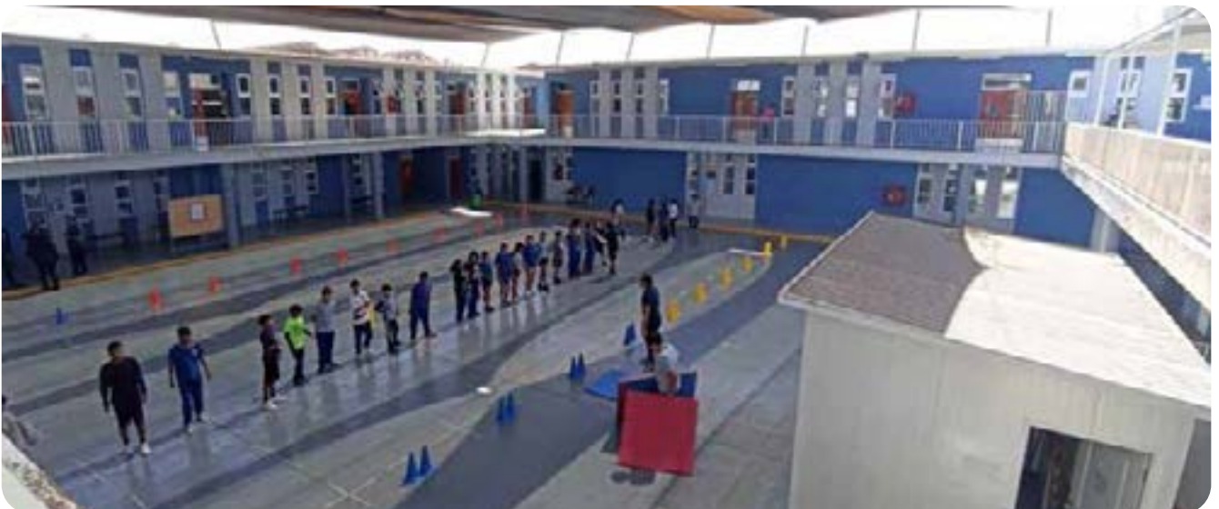
Sombreaderos en pasillos y patios del establecimiento.
