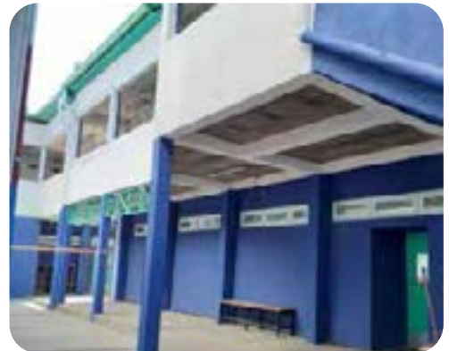
Junta entre pilares y muros.
