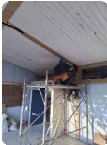
Instalación huinchas MDF sobre perfiles omega.
