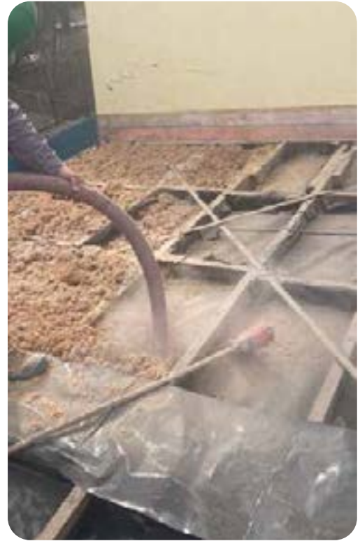
Aplicación primera capa de celulosa en cielo inclinado.
