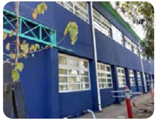
Escuela terminada, fachada oriente, sector Sociedad Constructora + Mesa de Hormigón, revestida en EIFS.
