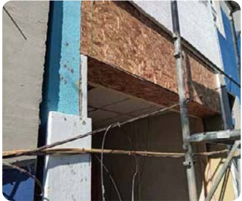
Sobre estructura revestida en OSB, para posteriormente recibir la barrera de aire y el sistema EIFS.
