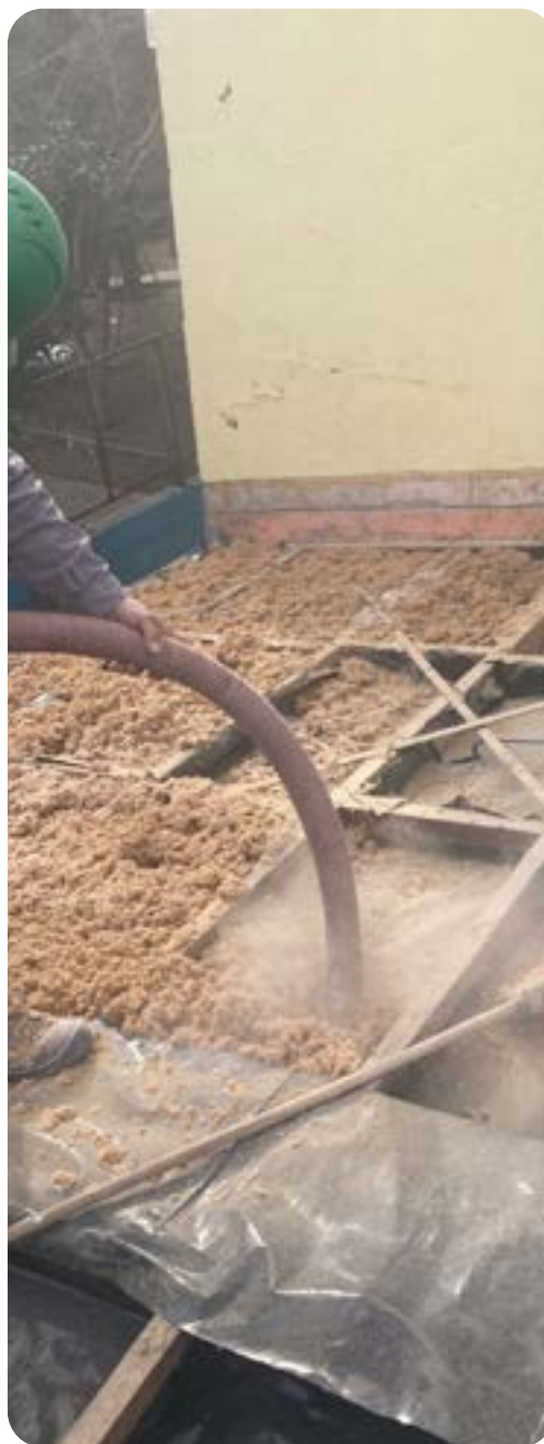
Celulosa aplicada en cielo horizontal
