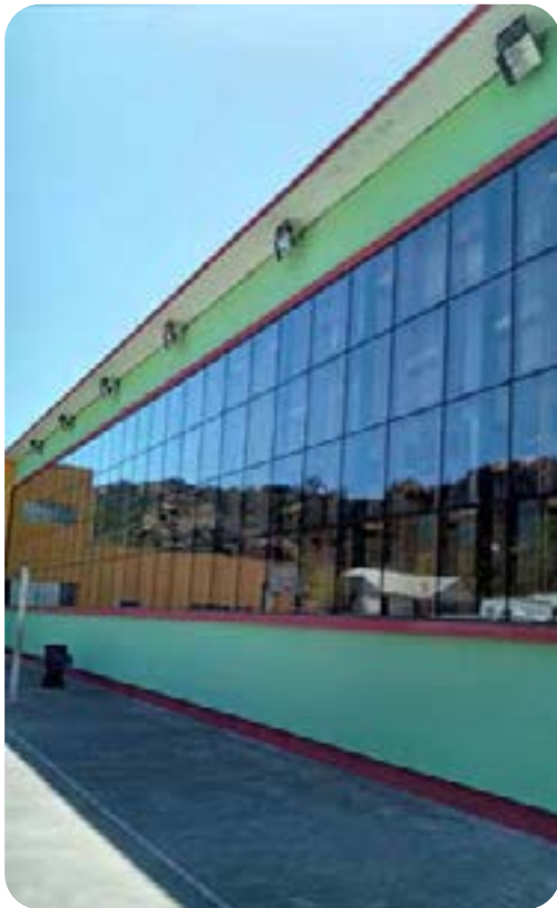
Vista exterior de Fachada Poniente finalizada.
