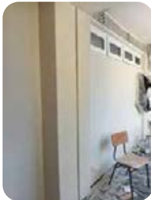
Junta entre pilares.
