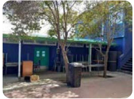
Escuela terminada, fachada oriente.
