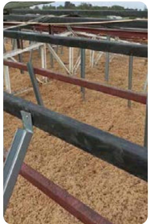
Aplicación de celulosa en cielo horizontal.
