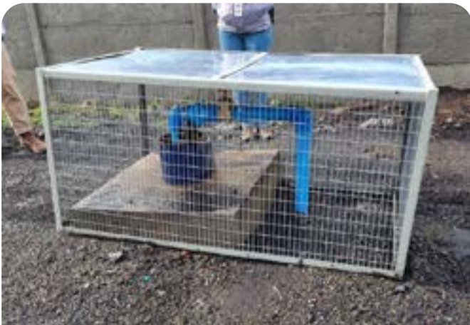
Pozos de Inyección.
