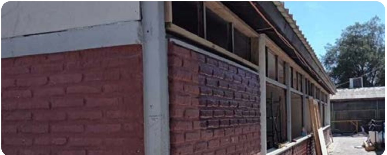
Ventanas montadas en sobre estructura, dejando la estructura de acero perdida al interior, eliminando el puente térmico. (5 procedimiento)
