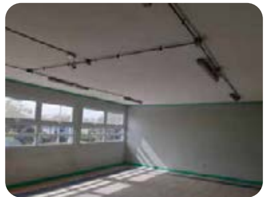
Escuela terminada, interior sala de clases.
