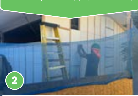
Instalación de EPS entre soleras y pie derechos. (3 procedimiento)
