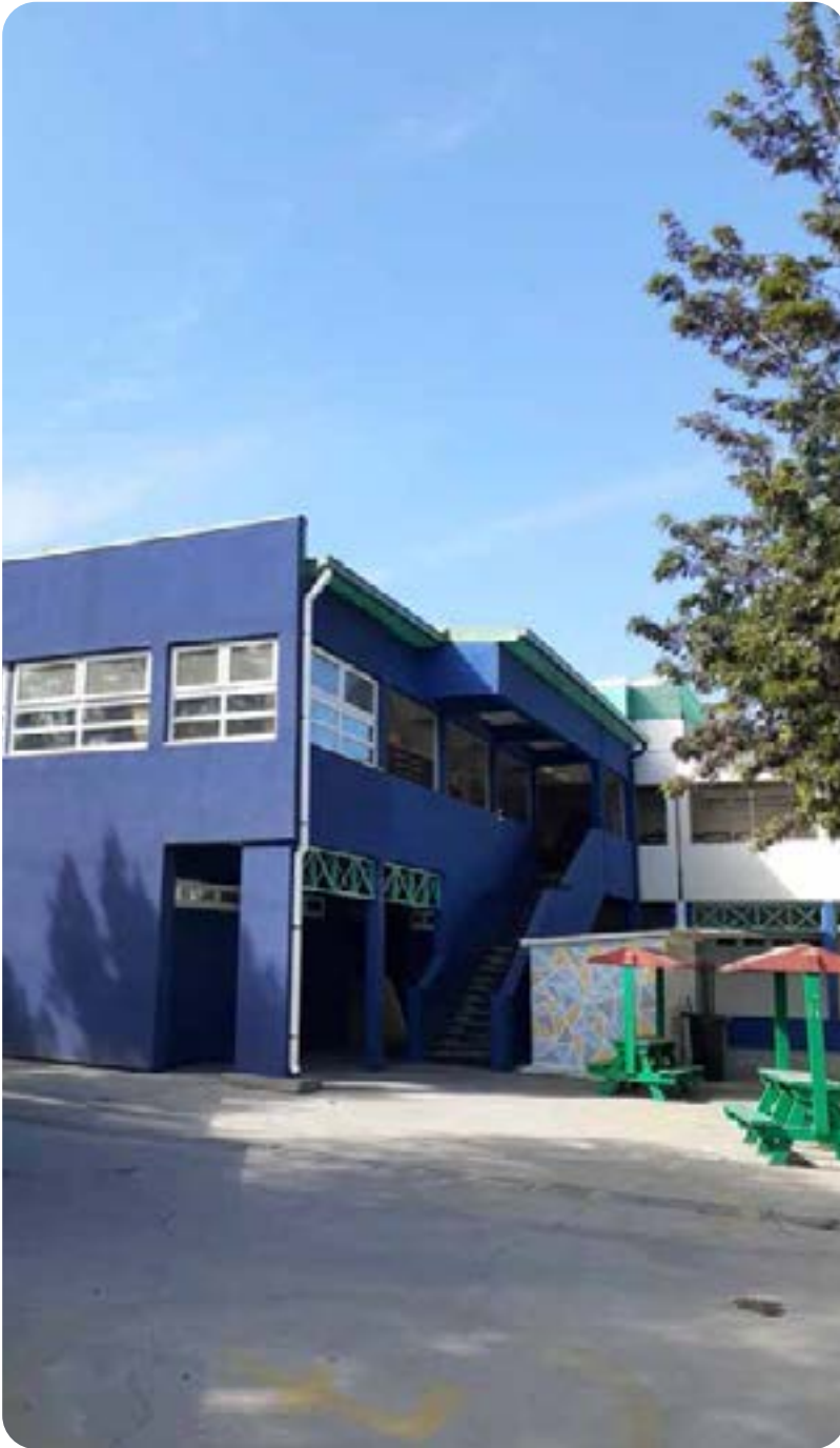
Escuela terminada fachada poniente.
