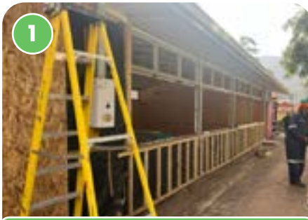
Instalación de barrera de vapor, pie derechos y soleras. (1 y 2 procedimiento)
