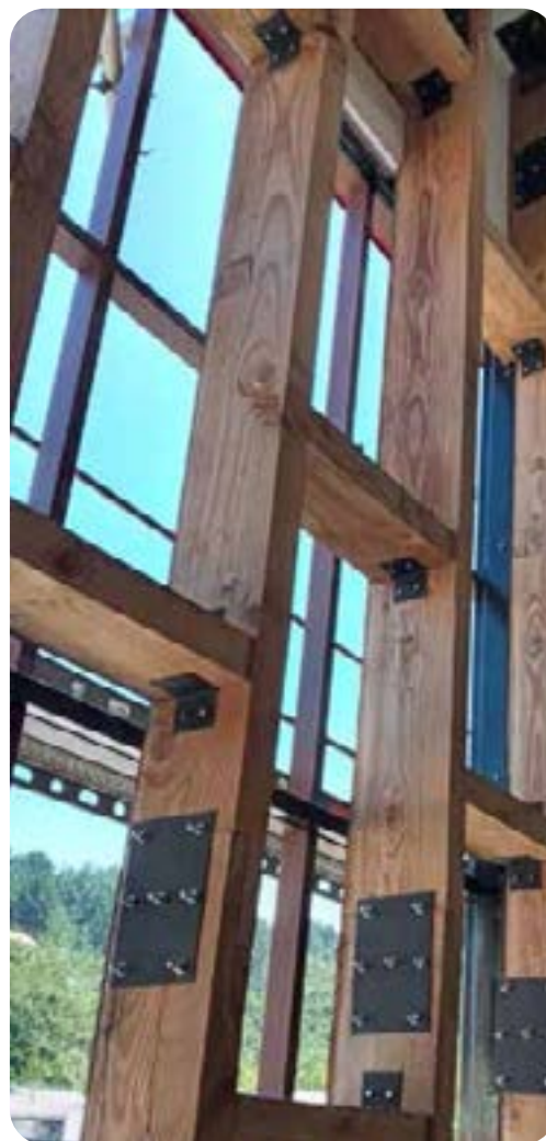
Vista interior de Fachada Poniente con estructura adicional por el exterior para recibir muro cortina.
