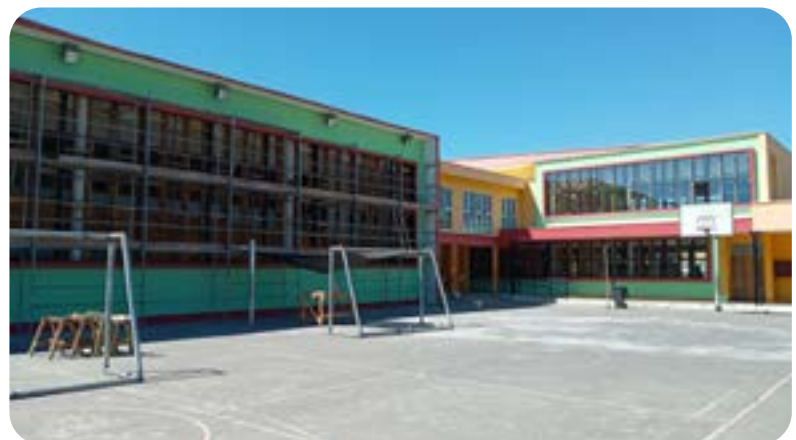
Fachada Poniente en proceso de montaje de muros cortina. Fachada Norte finalizada.
